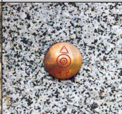
SFP Messingbolzen Ø 3 cm
