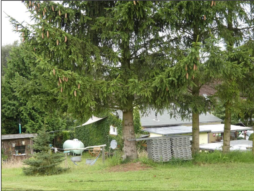
Abbildung 5: Bestehender Gebäudebestand im Plangeltungsbereich.
