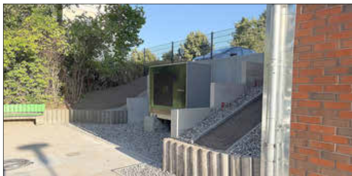
Sanierung Rathaus - Wärmepumpe
