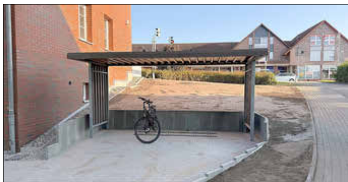
Sanierung Rathaus - Außenanlagen
