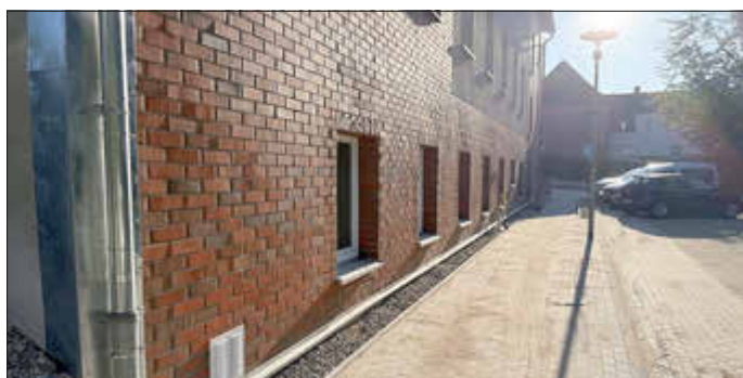
Sanierung Rathaus - Außenanlagen
