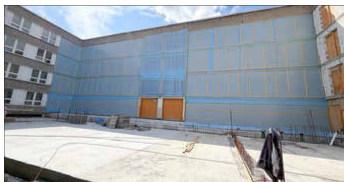
Erweiterungsneubau Regionale Schule
